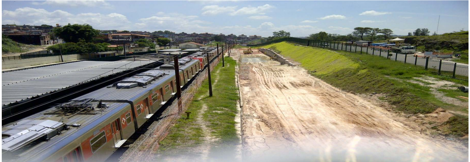
Muro de Contenção em Aracaré
