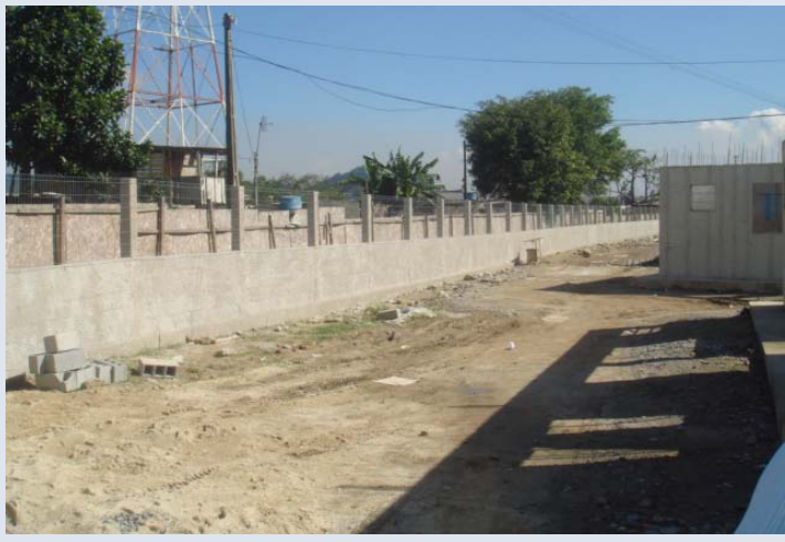
Vedação de Faixa – Cubatão e Guarujá
