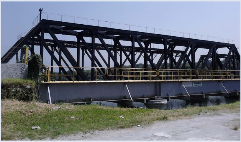
Adequação estrutural Ponte Casqueiro
