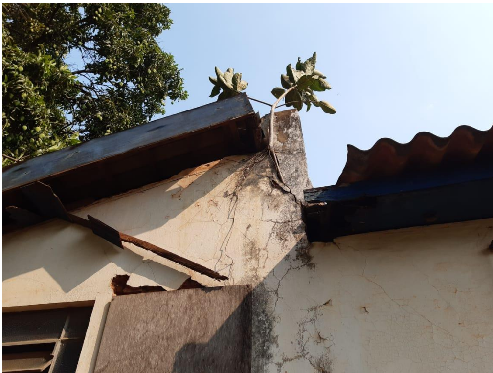
Foto 09 – Raízes e troncos de vegetação crescendo junto ao elemento estrutural
