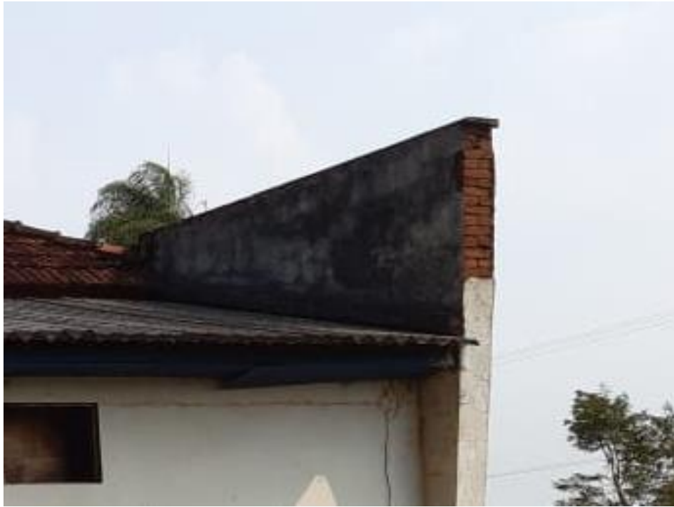
Foto 08 – Alvenaria em tijolo maciço
