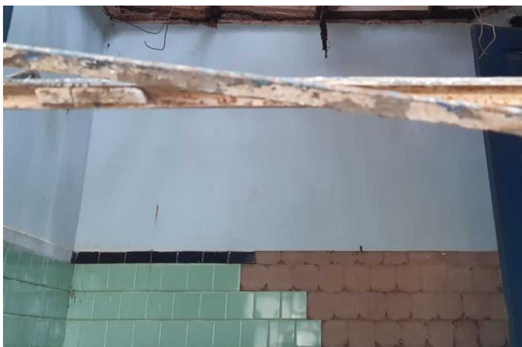
Foto 13 – Revestimento cerâmico descolado
