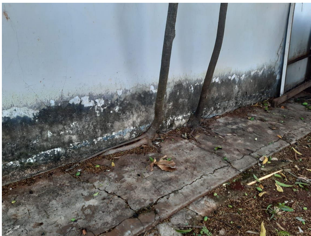
Foto 07 – Raízes e troncos de vegetação crescendo junto ao elemento de fundação.
