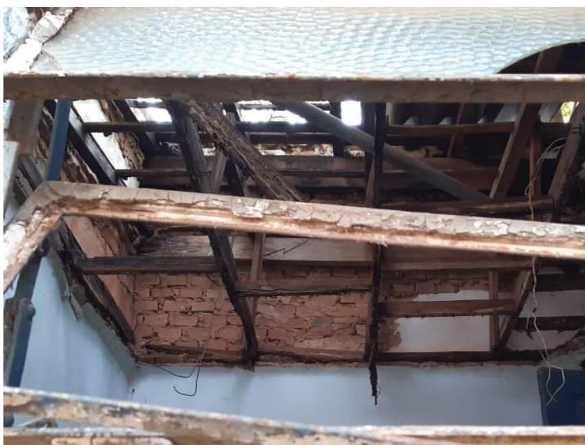
Foto 11 – Estrutura em péssimo estado de conservação, sem elemento de cobertura
