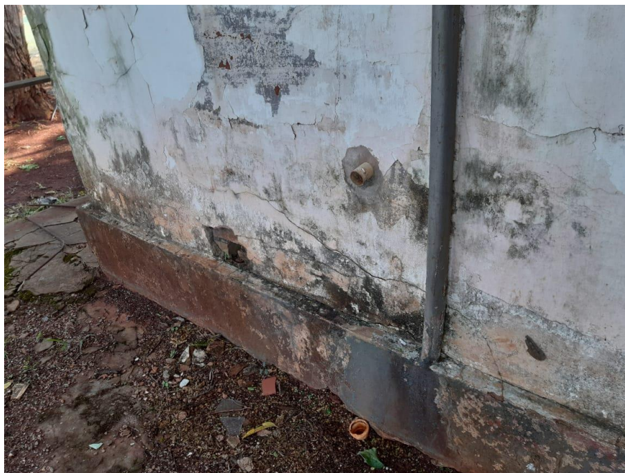
Foto 06 – Trincas e rachaduras iniciando no elemento de fundação.
