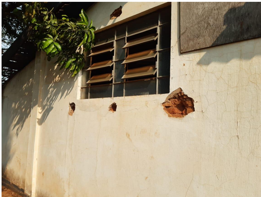
Foto 12 – Trincas e fissuras no reboco
