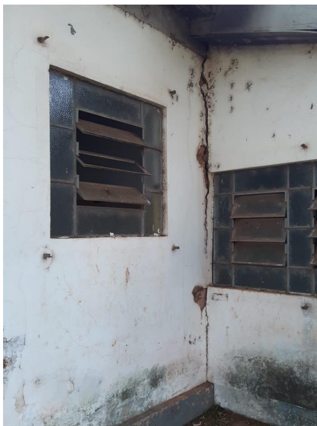
Foto 10 – Rachadura no encontro de paredes
